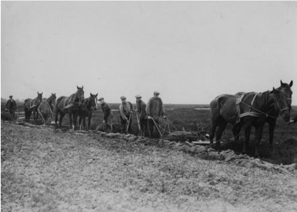
Het scheuren van de woeste gronden voorafgaand aan de bosaanleg (foto Drents Archief, Assen)
